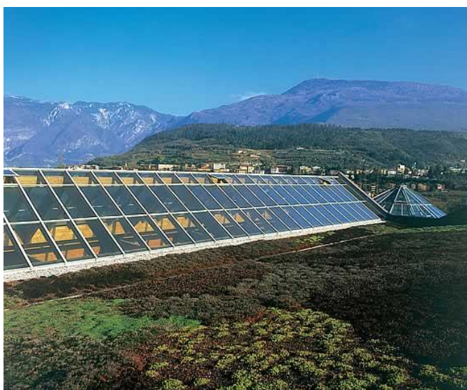
Foto: Pagoda Deposito vinacce Tetto Verde
